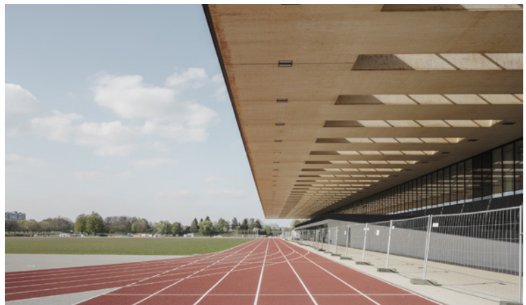
Das 19 Meter auskragende Vordach ist eine spezielle Holzkonstruktion aus vorgefertigten Hohlkastenelementen, die ohne aufwändiges Hilfsgerüst montiert werden kann. Foto: A. Amoretti
