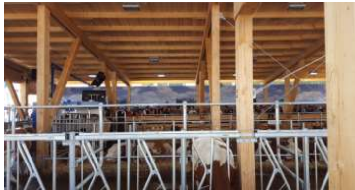
Milchviehstall in Holzbauweise auf dem ZLF, Foto H. Förster, ZWFH
